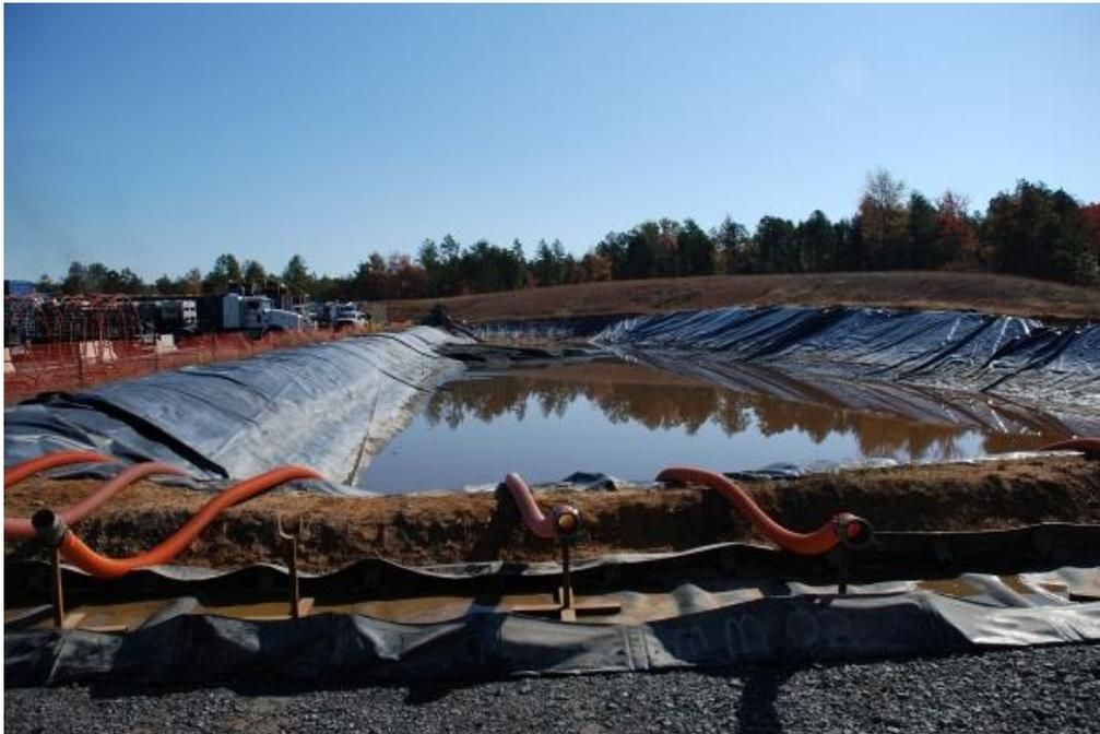
Abbildung 7: Lagerung des Flowbacks aus dem Fracking in einem offenen Becken (Schattenblick 2014)
